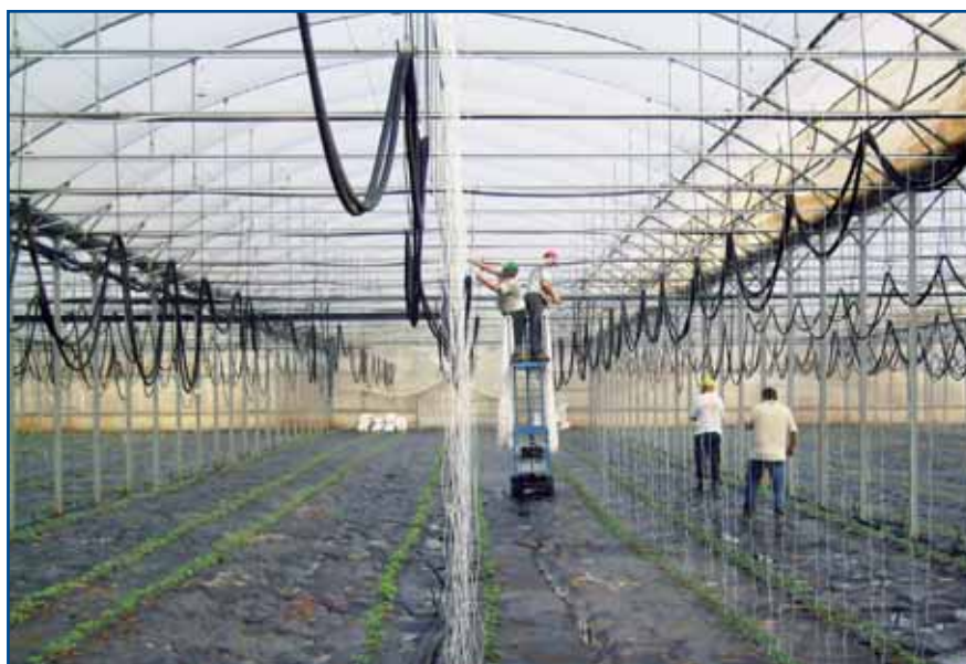
Fig. 8 - Sistemazione dei fili in serra con l'uso della piattaforma
