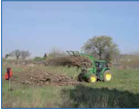
Fig. 6 - Accumulatrice della ditta ZPZ snc in fase di raccolta
