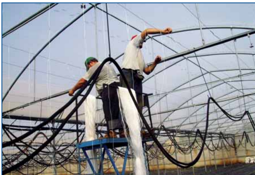
Fig. 7 - Sistemazione dei fili in serra con l'uso della piattaforma
